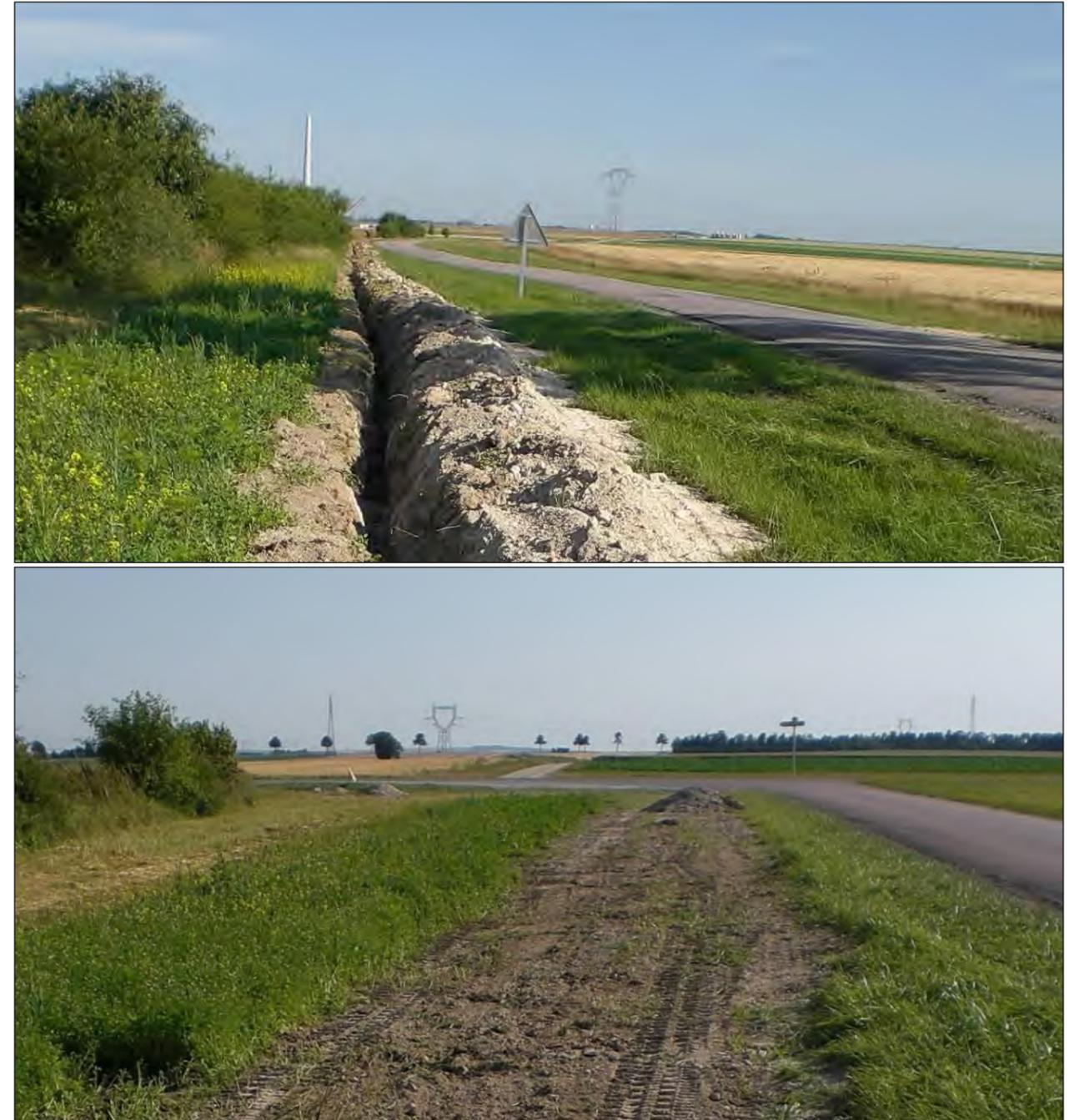
Photo 160 : Rebouchage de tranchée après passage des câbles électriques (Source : BE JC)
